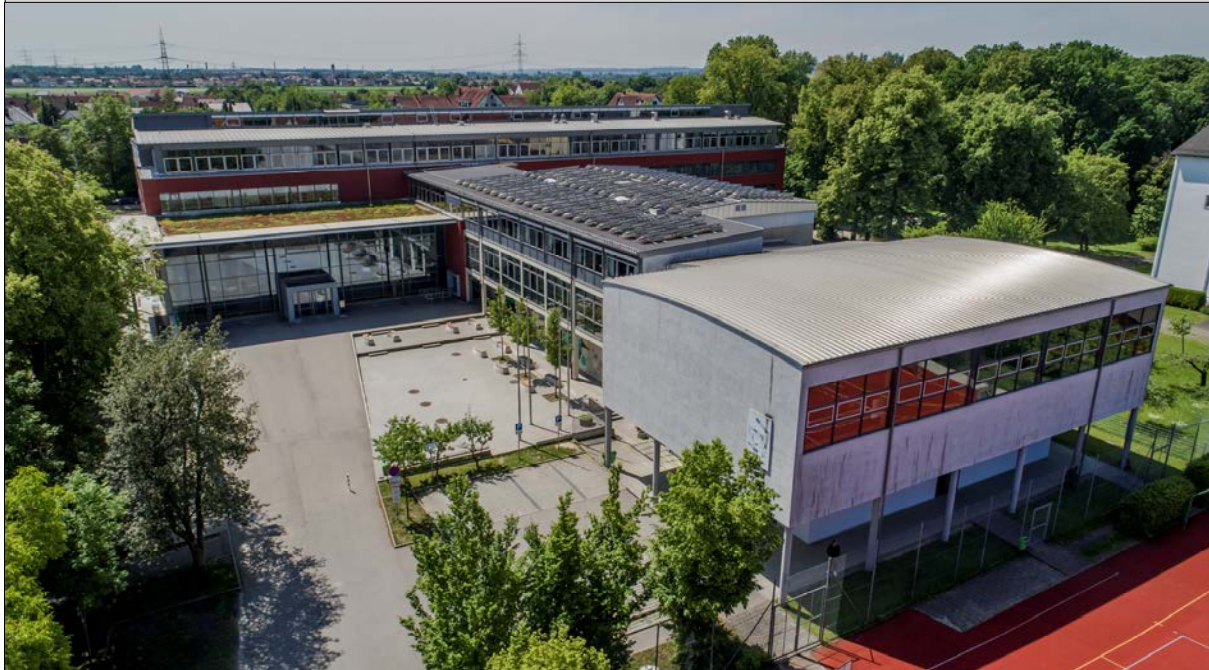
Schulgebäude (Ansicht von Nordosten)
