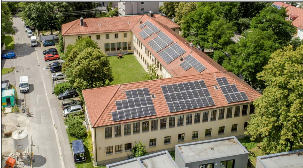
Gebäude (Ansicht von Südosten)
