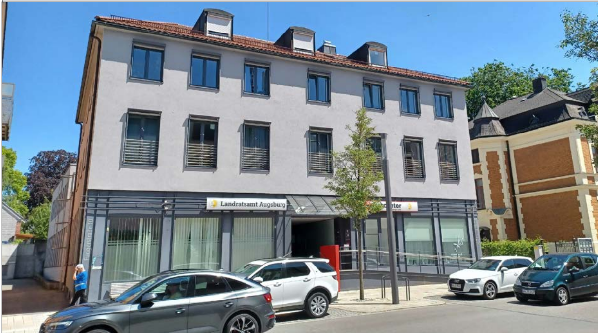
Gebäude (Ansicht von Westen)
