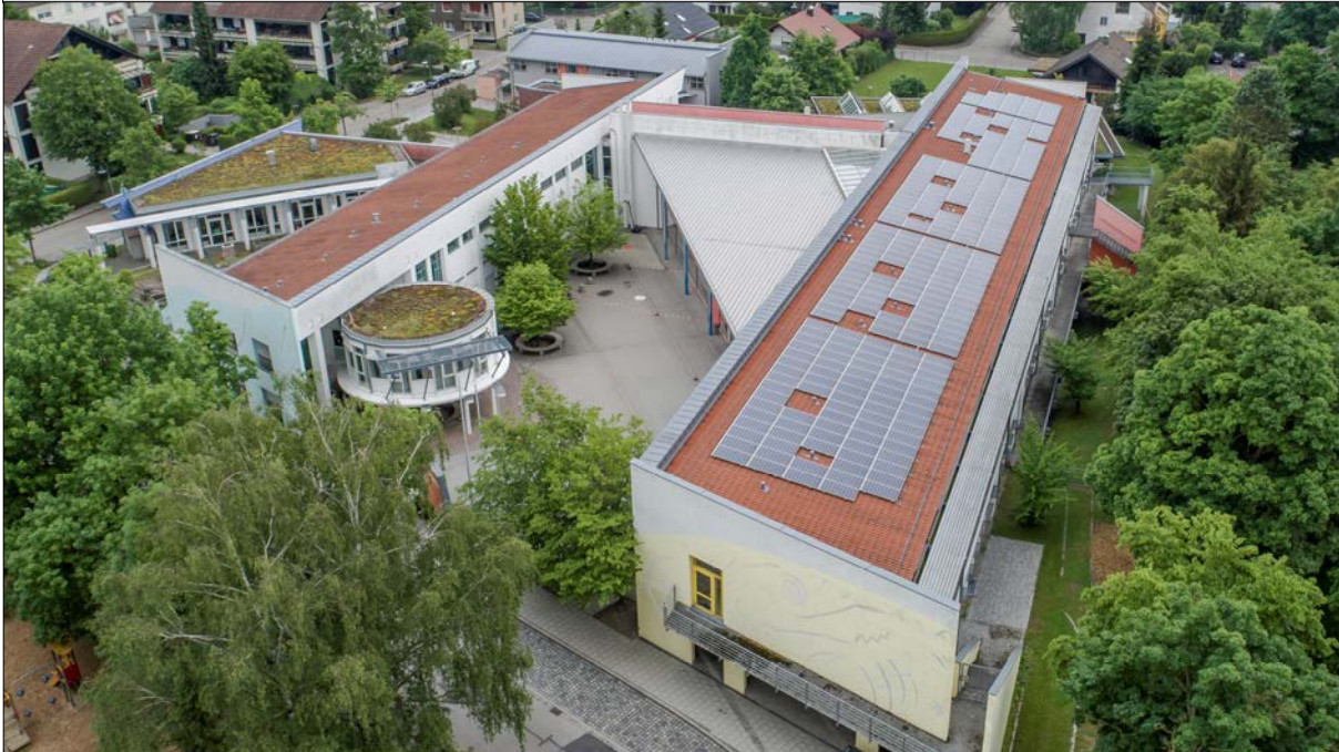
Schulgebäude (Ansicht von Südwesten)
