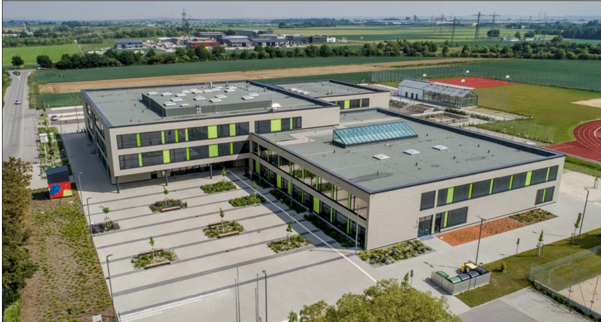
Schulgebäude (Ansicht von Südwesten)
