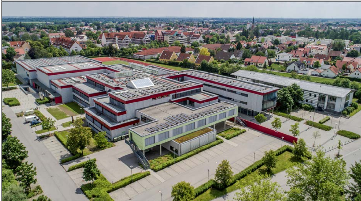
Schulgebäude (Ansicht von Nordwesten)
