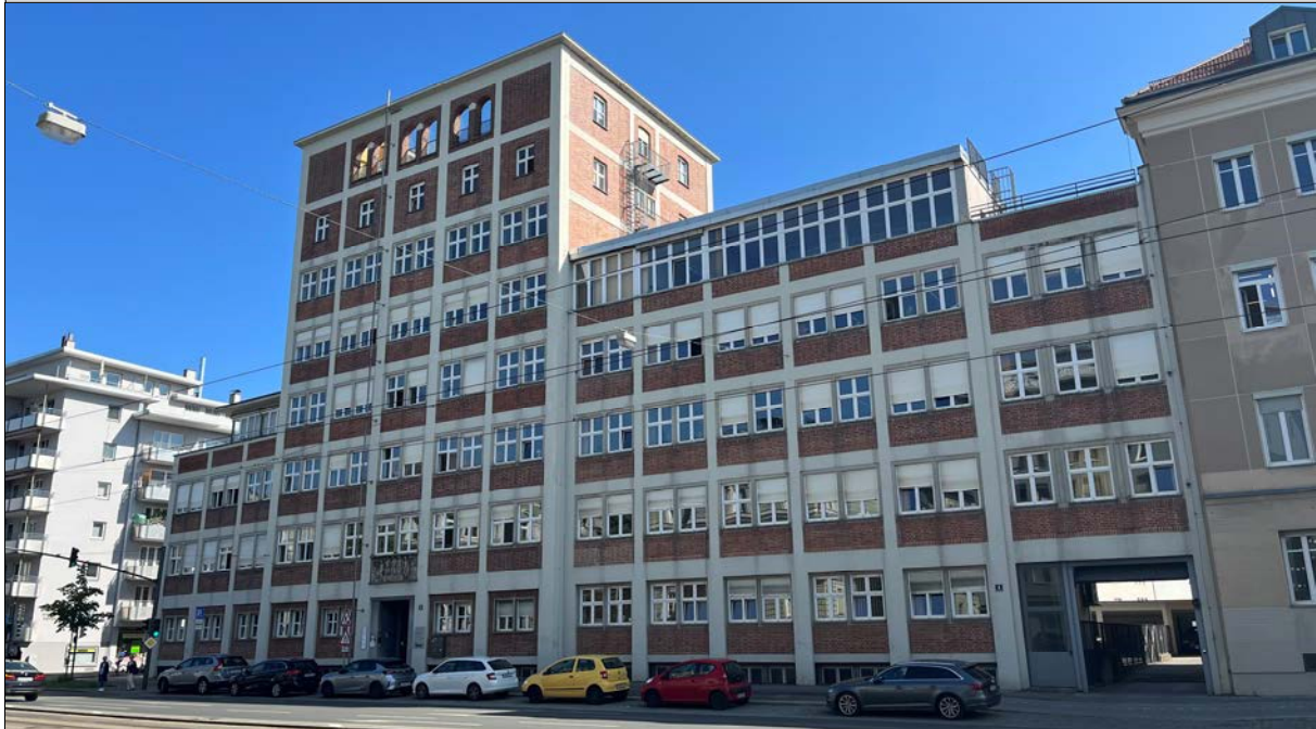
Gebäude (Ansicht von Süden)
