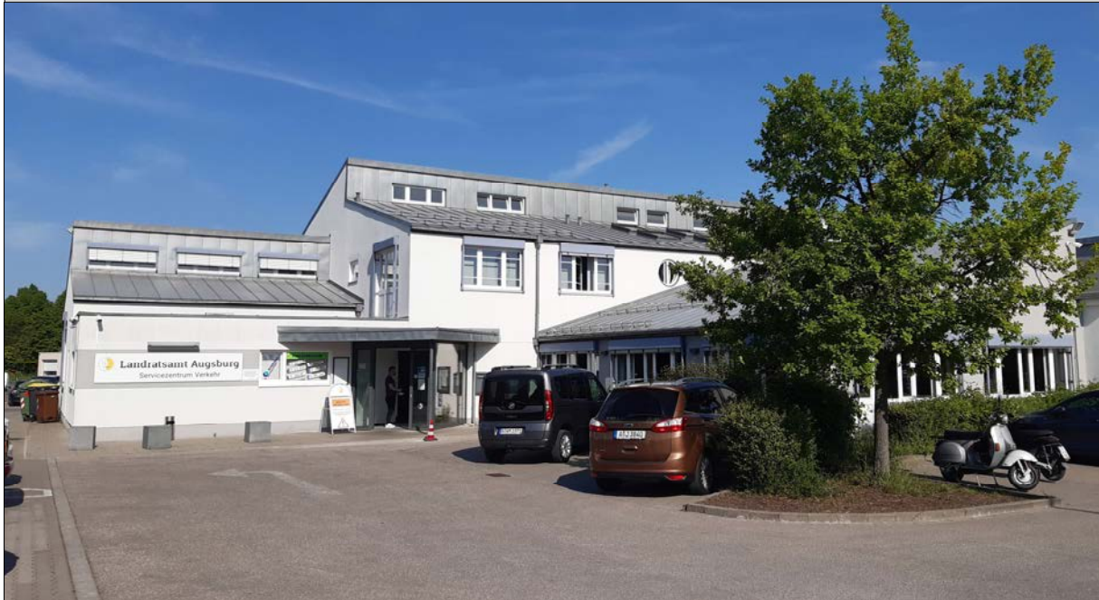
Gebäude (Ansicht von Südosten)
