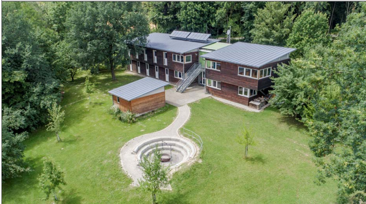
Gebäude (Ansicht von Südosten)
