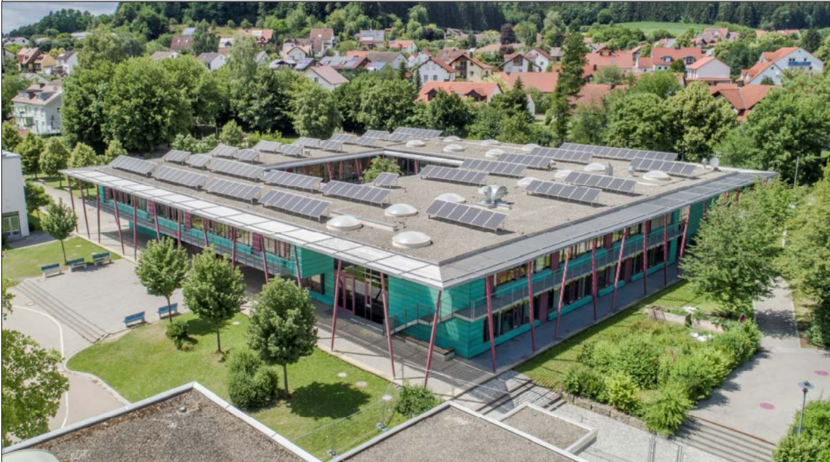
Schulgebäude (Ansicht von Südosten)
