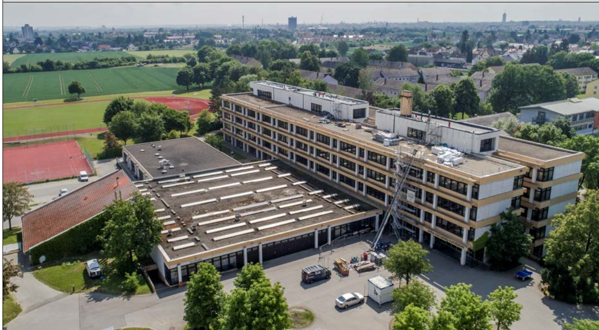
Schulgebäude (Ansicht von Nordwesten)
