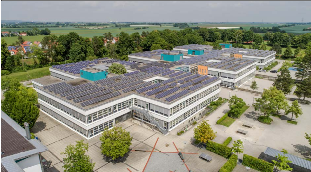
Schulgebäude (Ansicht von Südwesten)
