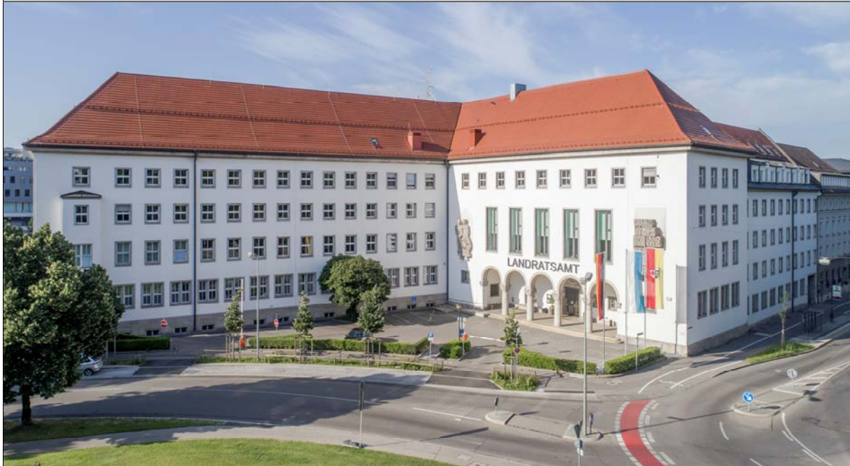
Gebäude (Ansicht von Nordosten)
