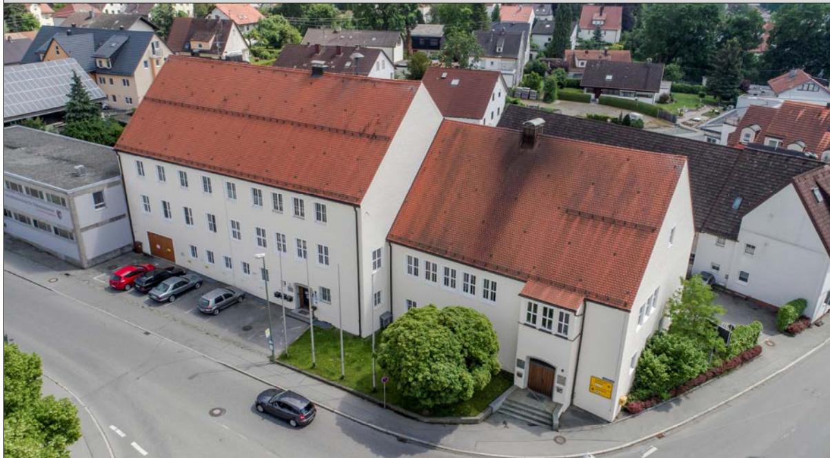
Gebäude (Ansicht von Nordwesten)
