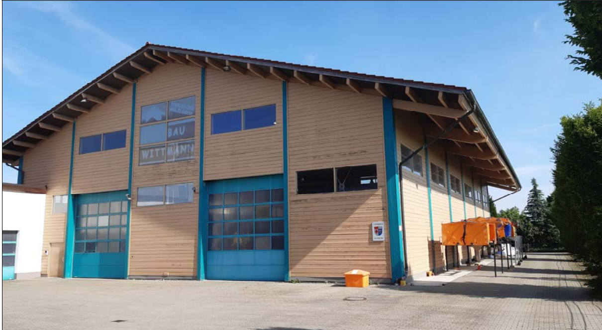
Gebäude (Ansicht von Südosten)
