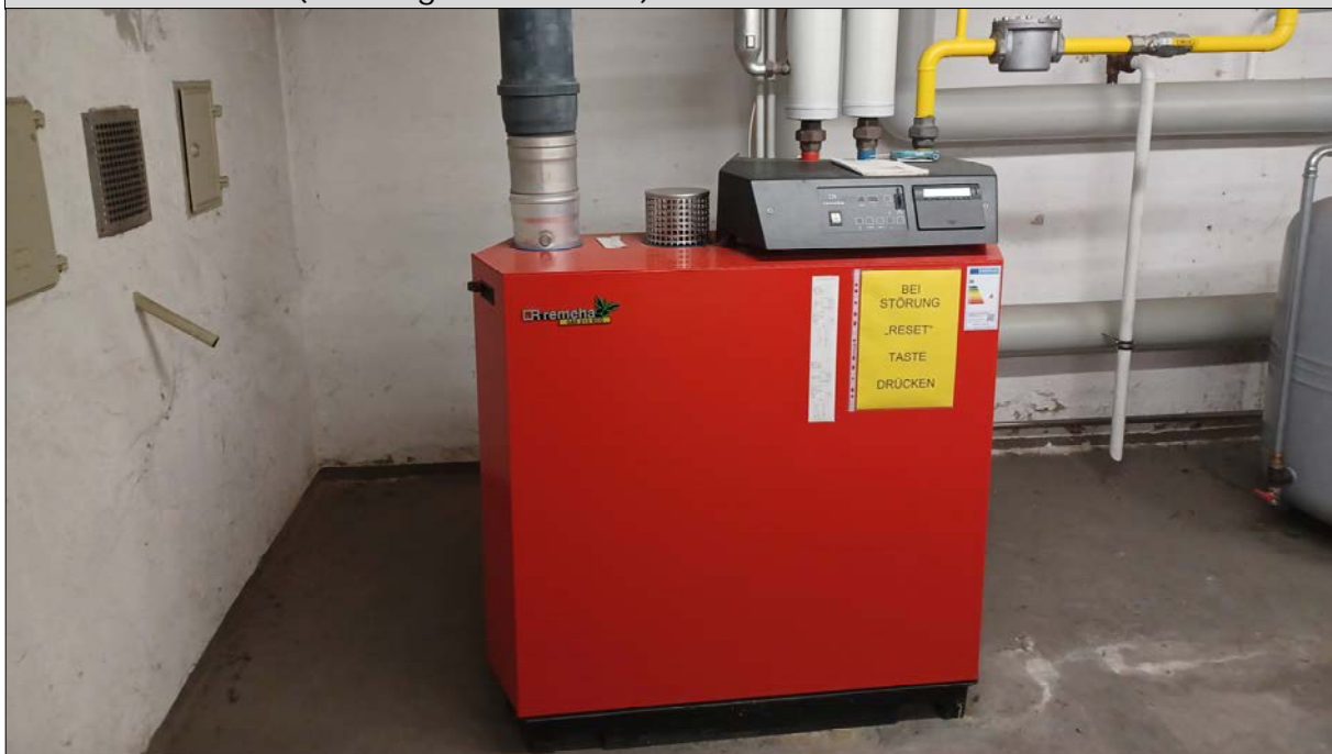
Brennwertkessel (Heizungsraum im UG)
