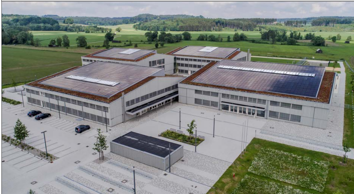
Schulgebäude (Ansicht von Südosten)
