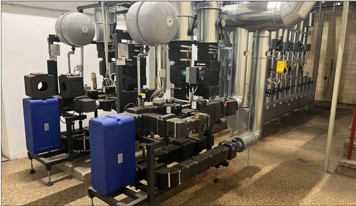
Wärmetauscher und Heizkreisverteiler (Heizungsraum im KG)
