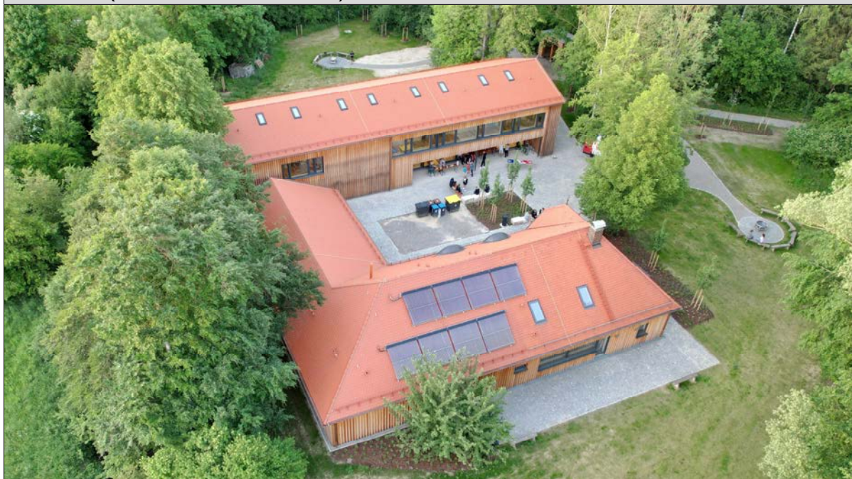
Gebäude (Ansicht von Südosten)
